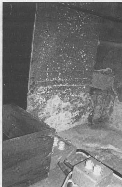
Rivning efter Kromverkstaden 1979.
